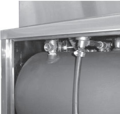
L'une des soupapes de surpression est située sur la partie arrière gauche du chauffe-eau.
